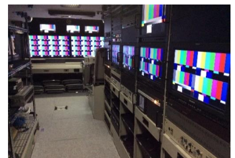
内部 VEラック後方から
